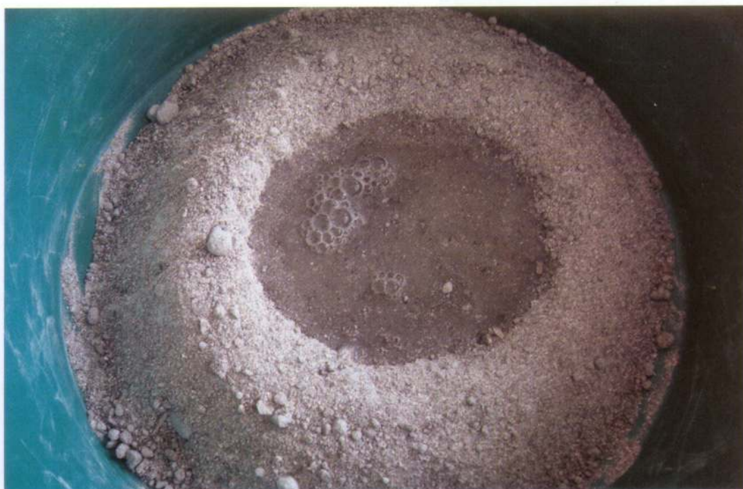
Fig. 2 – Mistura com água para dar a consistência necessária.
