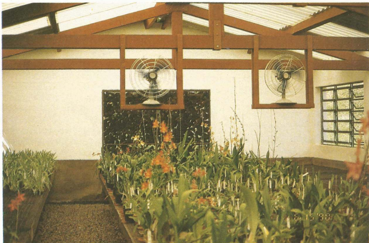
Estufa mostrando sistema de resfriamento. Os ventiladores ajudam a circular o ar para evitar o aquecimento das plantas.
