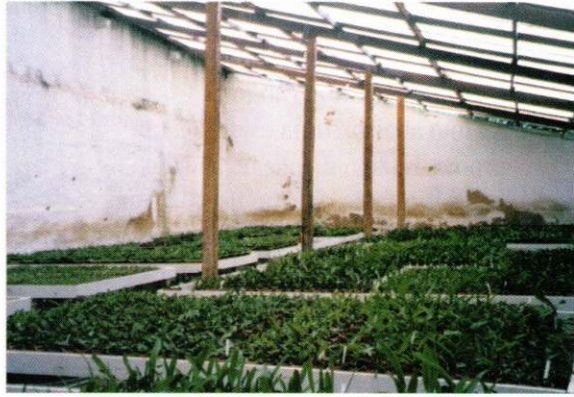
Estufa de alvenaria (Orchidcastle - Petrópolis), com 250m 2 (10x25), utilizando telhas de fibra de vidro, intercaladas com fibrocimento.
