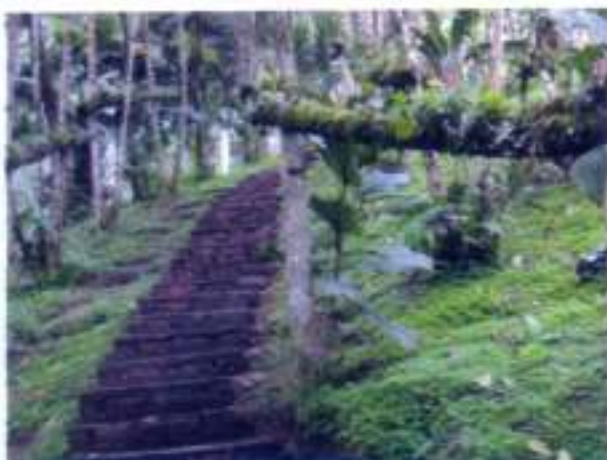
Fig. 5. Galhos encontrados no chão da floresta foram montados como segmentos do corrimão, acompanhando a escada.
